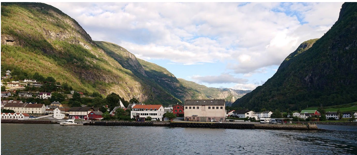
5. Eksisterande bygg sett frå fjorden. Grensa for UNESCO Verdsarvområde går i kaikanten. Aurlandsvngen er også eit naturleg startpunkt for Aurlandsdalen, både historisk (driftevegen) og med tanke på dagens turistnæring. Verdsarvsenteret vil fungera som eit startpunkt begge vegar, og som eit knytnepunkt for lokalsamfunn og lokal næring.
